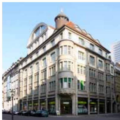
Schrödterhaus, Leipzig Technisches Gebäudemanagement
