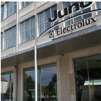
Elektrolux, Nürnberg Technisches Gebäudemanagement, Reinigung, Sicherheit
