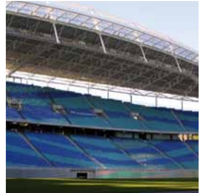
Stadion Leipzig Projektbegleitung
