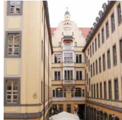
Barthels Hof, Leipzig Property Management u. Gebäu- demangement, Energy Service
